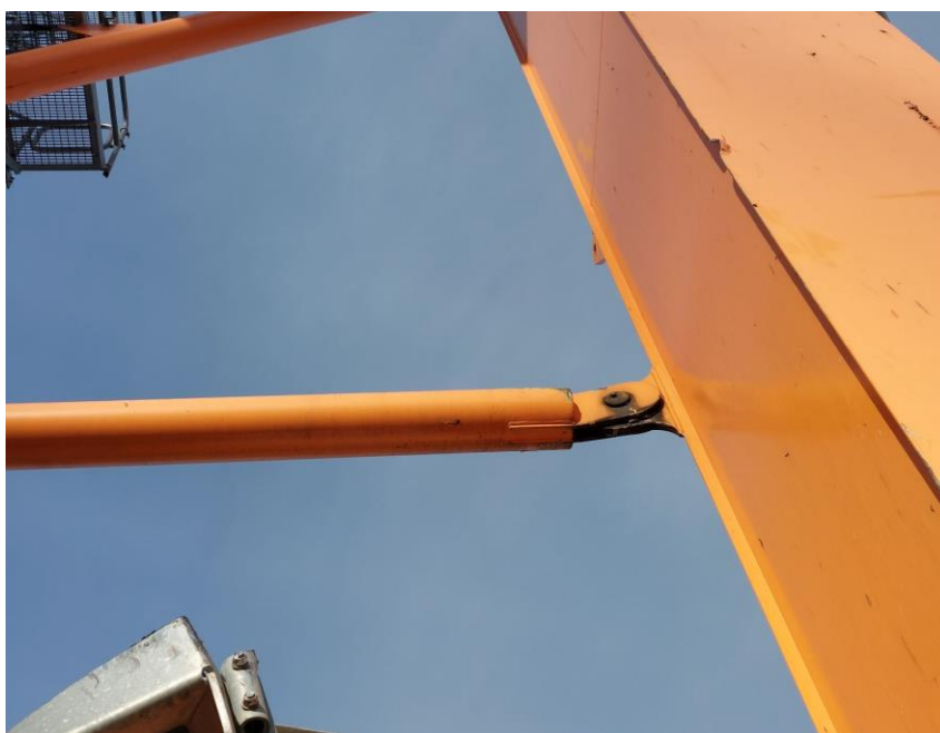
Slika 2: Poškodba veznega droga z sorniki
